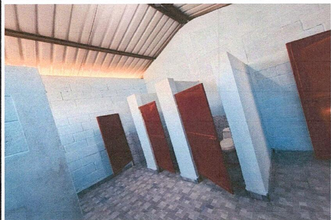
Foto 1: Mejoramiento de reparación de baños.
